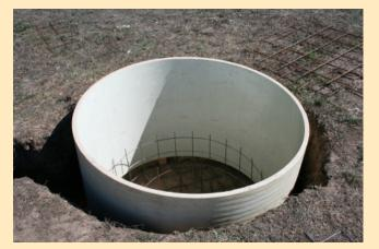
1.4m dia FRP pipe prior to concrete pour
